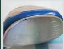
①傷がつかないように設置にマスクング
